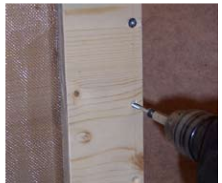
Bild 10: Die Kiste verschrauben.
